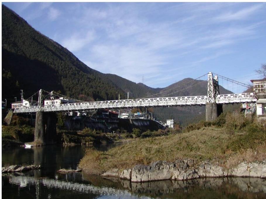
加茂郡白川町にある飛騨川を渡る、大正15年完成の鋼補剛トラスによる3径間2ヒンジの吊橋。主塔も鋼トラスからなり、現存する吊橋としては非常に珍しい鋼吊橋。社団法人土木学会の選奨土木遺産に選出。
