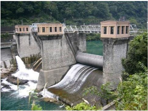
加茂郡白川町の飛騨川にある発電出力が27,000kWの重力式コンクリートダム。大正15年に建設されたレンガ造りのレトロな雰囲気漂う水力発電用のダム。
