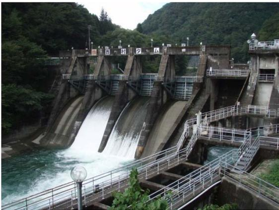
高さ19.50m、4門のラジアルゲートを持つ重力式コンクリートダム。馬瀬川本流をせき止め、導水路によって、飛騨川の瀬戸第2発電所へ送水するための取水ダムである。昭和13年建設。
