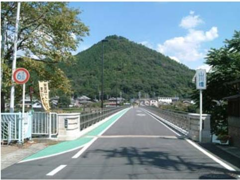
加茂郡川辺町にある飛騨川を渡る、昭和12年に完成したRCラーメン形式の橋。現存する同形式の橋では最大級の長さを誇る。山川橋の上流には川辺漕艇場があり、平成24年に開催予定の岐阜国体のボート競技会場に内定。
