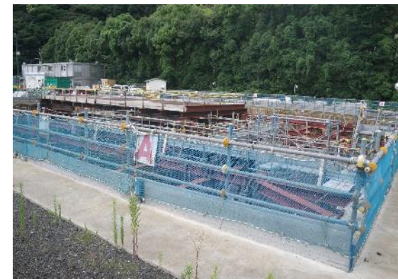
高浜発電所現地状況
