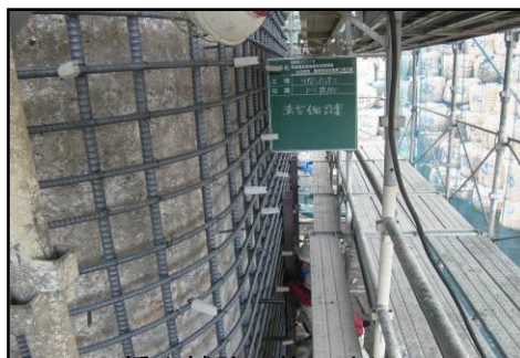
橋脚補強（施工中）
