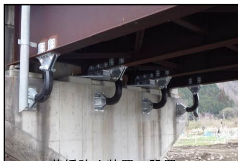
落橋防止装置の設置
