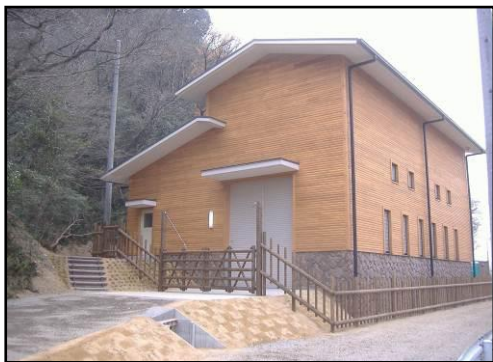
実施後（揚水機場）
