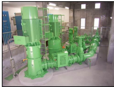
実施後（揚水機場内ポンプ）
